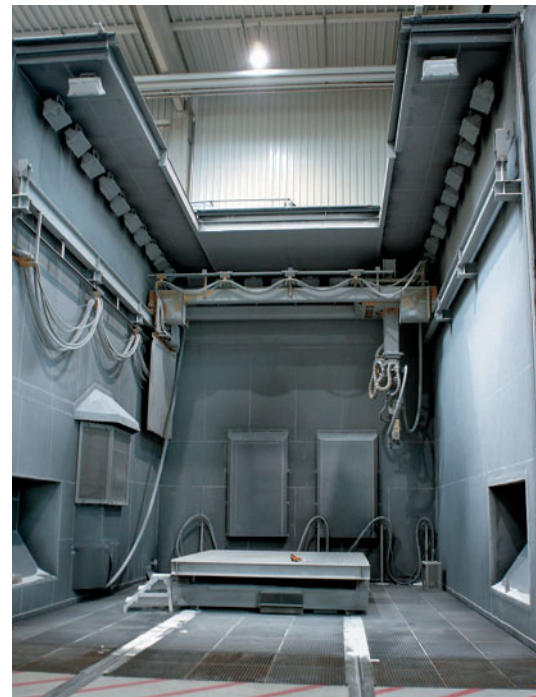
Strahlhalle mit aufklappbarem Dach und Gleiswagen zum Transport der Werkstücke.
